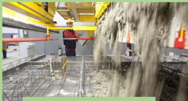
Fertigteilewerk Max Bögl
