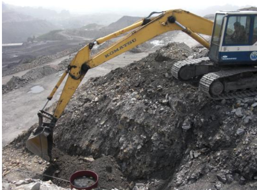
Abbildung 4: Schürfgrube für Feldversuche
