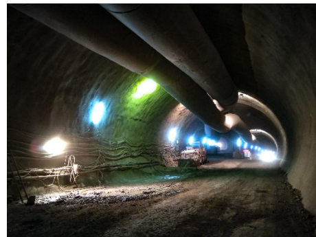
Exkursion zum Tunnel Ober-/Untertürkheim (Foto: Feinendegen)
